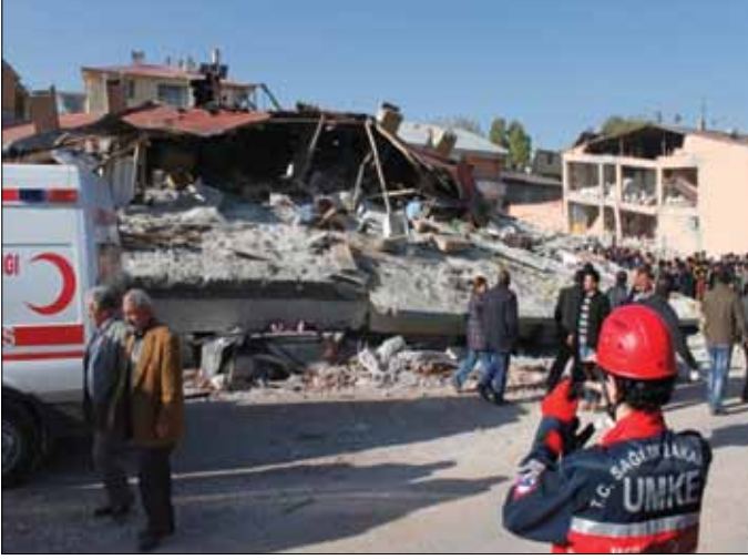
Resim 1. Trabzon UMKE'nin görev aldığı 6 katlı binanın enkazı
